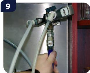
Закройте клапан подачи воды и отсоедините заборную головку от промывочного адаптера.
