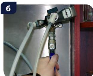
Откройте клапан подачи воды на водопроводе.
