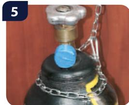
Зафиксируйте баллон СО<sub>2</sub> стальной цепью.
